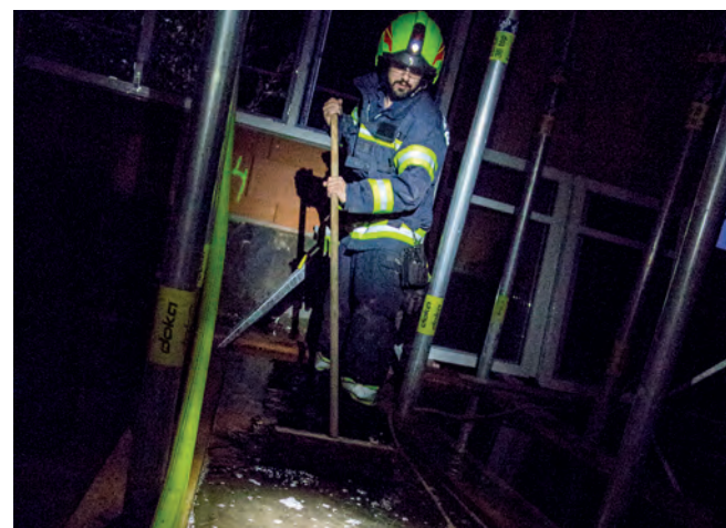
Einsatz im Caritas Kindergarten bei den Umbauarbeiten
