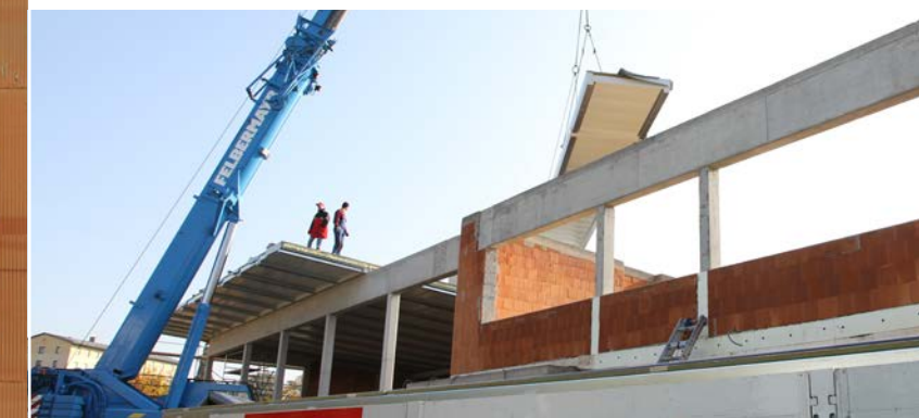
22. Oktober 2011 – Montieren der Dachelemente
