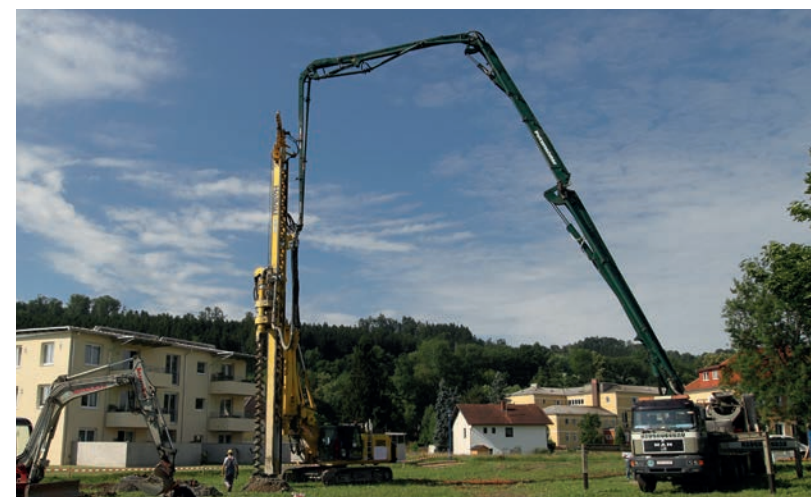
21. Juni 2011 – Bohren und Füllen von Betonpfählen
