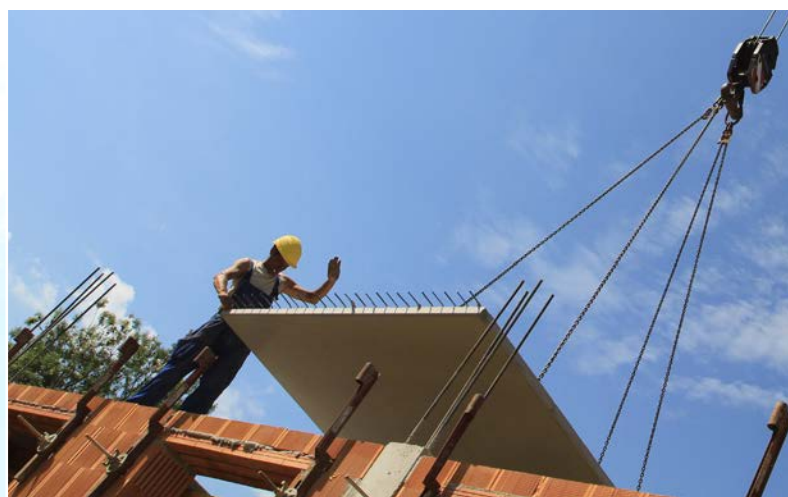
31. August 2011 – Aufsetzen der Fertigdecke
