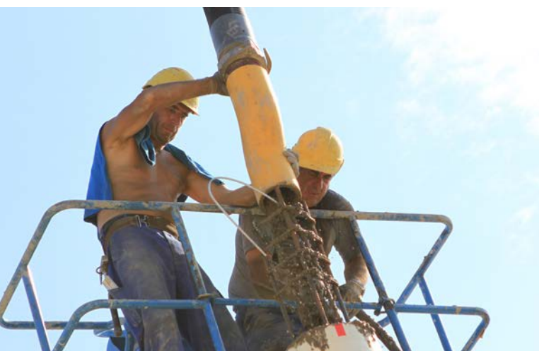
18. August 2011 – Betonieren der Säulen
