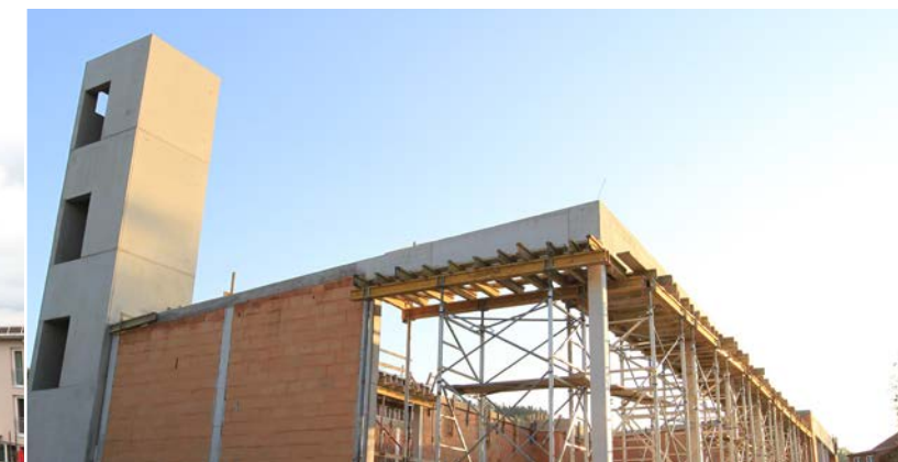
6. Oktober 2011 – Fertigstellung Schalung für Dach
