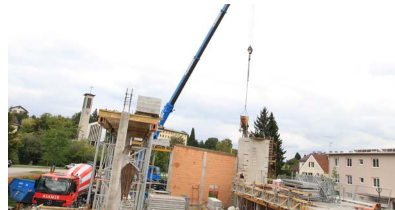
9. September 2011 – Betonieren des Schlauchturms
