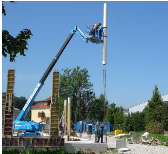
18. August 2011 – Schalung der Säulen
