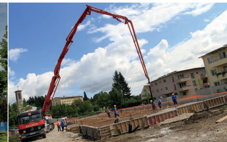
9. August 2011 – Betonieren des Fundamentes
