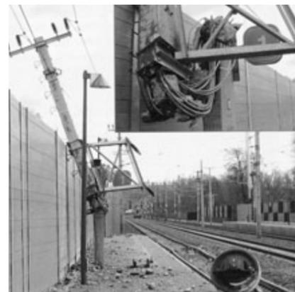
Eine der Waggonachsen verwandelte sich in ein fliegendes Geschoss und kappte einen Betonmasten! Andernfalls wäre sie vermutlich auf der Fahrbahn der Unterführung gelandet...
